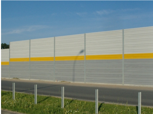
Ekran z paneli metalowych (pochłaniający, nieprzezroczysty, konstrukcja na fundamencie)
