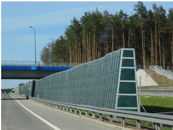
Ekran ziemny (pochłaniający, nieprzezroczysty, konstrukcja samonośna)
