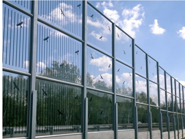
Ekran z paneli ze szkła akrylowego (odbijający, przezroczysty, konstrukcja na fundamencie)
