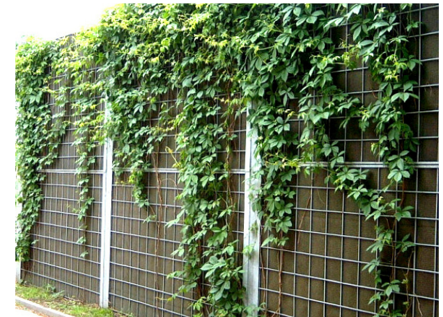
Ekran z paneli typu „zielona ściana” (pochłaniający, nieprzezroczysty, konstrukcja na fundamencie)
