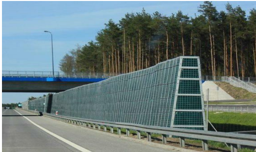
Ekran ziemny (pochłaniający, nieprzezroczysty, konstrukcja samonośna)
