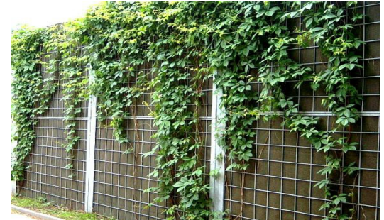
Ekran z paneli typu „zielona ściana” (pochłaniający, nieprzezroczysty, konstrukcja na fundamencie)
