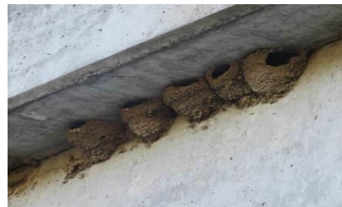
fol. gniazda jaskółek oknówek na obiekcie mostowym w km 78+000
