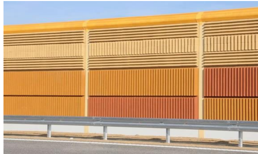
Ekran z okładziną betonową (pochłaniający, nieprzezroczysty, konstrukcja na fundamencie)
