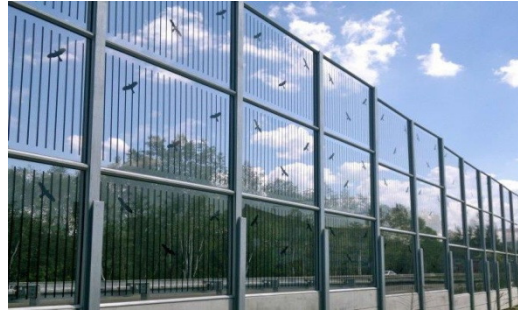
Ekran z paneli ze szkła akrylowego (odbijający, przezroczysty, konstrukcja na fundamencie).
