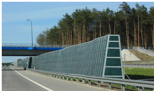
Ekran ziemny (pochłaniający, nieprzezroczysty, konstrukcja samonośna)
