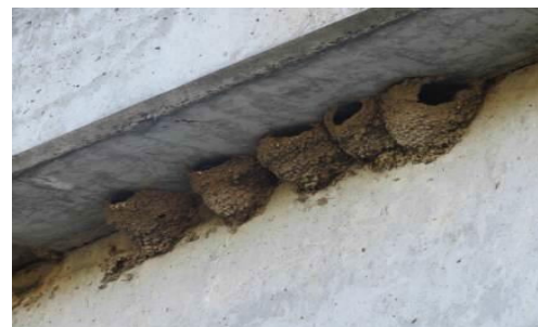
fot. gniazda jaskółek oknówek na obiekcie mostowym w km 78+000
