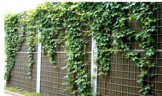
Ekran z paneli typu „zielona ściana” (pochłaniający, nieprzezroczysty, konstrukcja na fundamencie)
