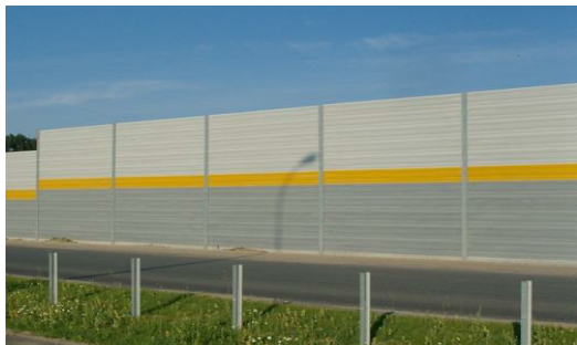
Ekran z paneli metalowych (pochłaniający, nieprzezroczysty, konstrukcja na fundamencie).
