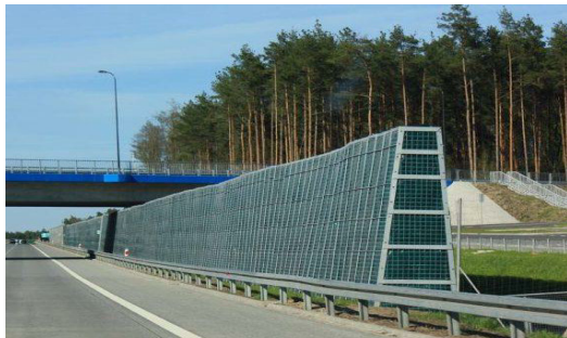
Ekran ziemny (pochłaniający, nieprzezroczysty, konstrukcja samonośna)
